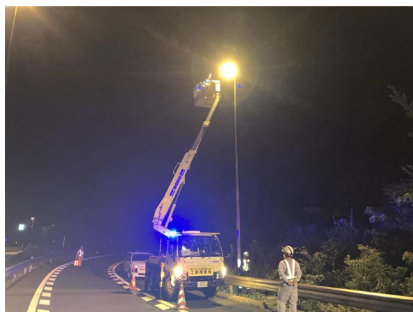
《点検作業状況》
