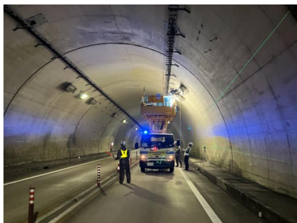
《設備更新作業状況》
