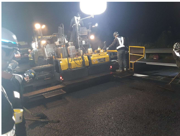
<舗装補修工事>
