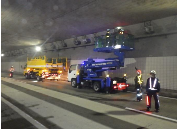
《点検作業状況》
