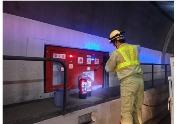
《清掃作業状況》
