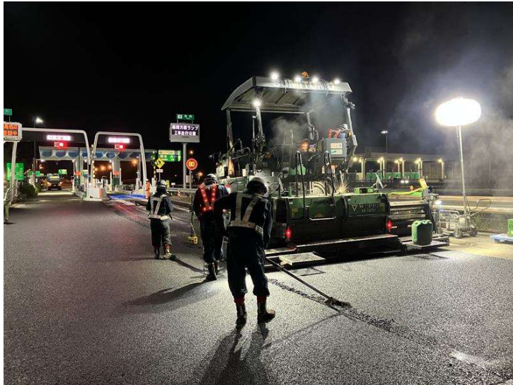
< 舗装補修工事 >
