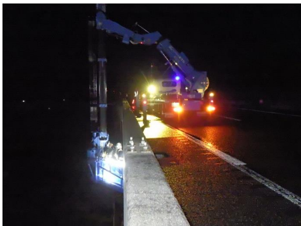
《点検状況写真》
